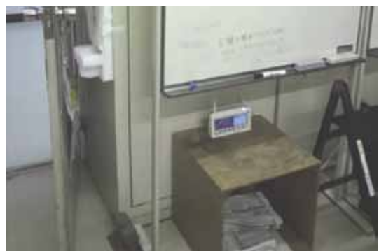
写真4 2階分電盤に設置した省エネナビ
