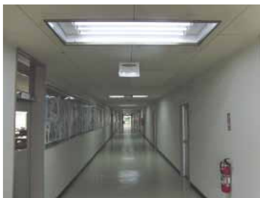
写真3 電気電子システム専門棟2階廊下に導入された直管型LED照明
