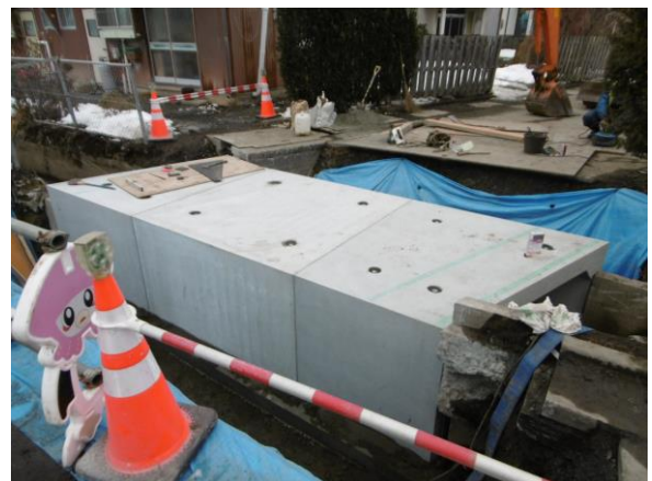
図 16 H 市 掛替工事でのプレキャストボックスカルバート敷設状況
