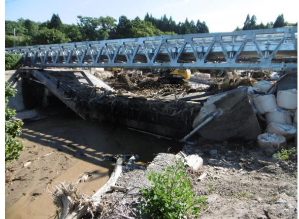
図 4 崩落した小赤川橋と仮設橋梁（トラス）、2021 年、青森県むつ市
