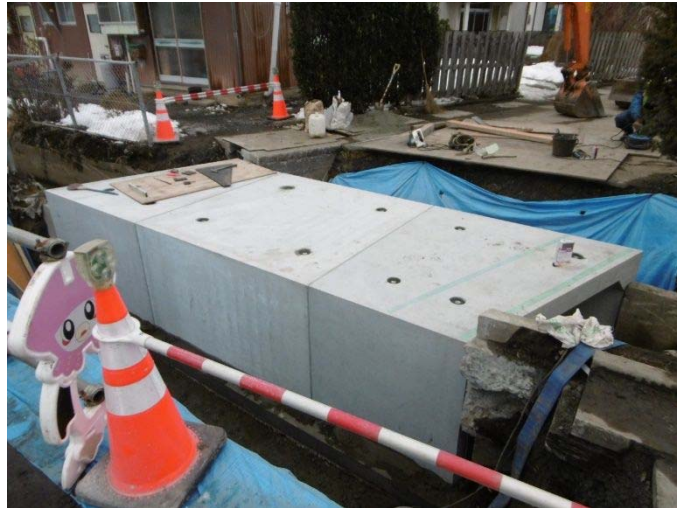
図 25 H 市 掛替工事でのプレキャストボックスカルバート敷設状況
