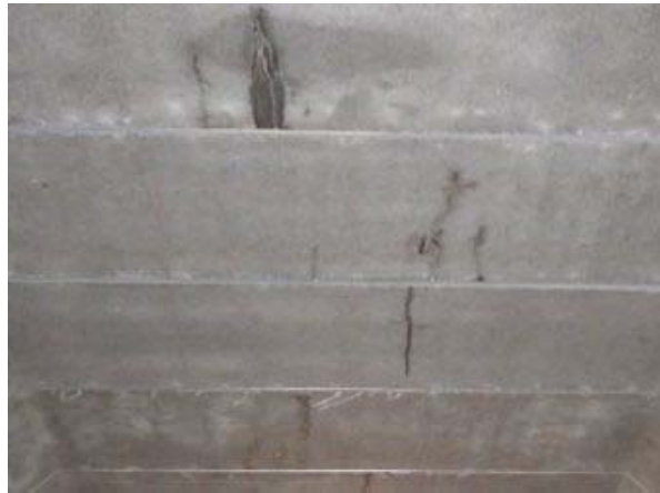
図 3 ひび割れと漏水状況
