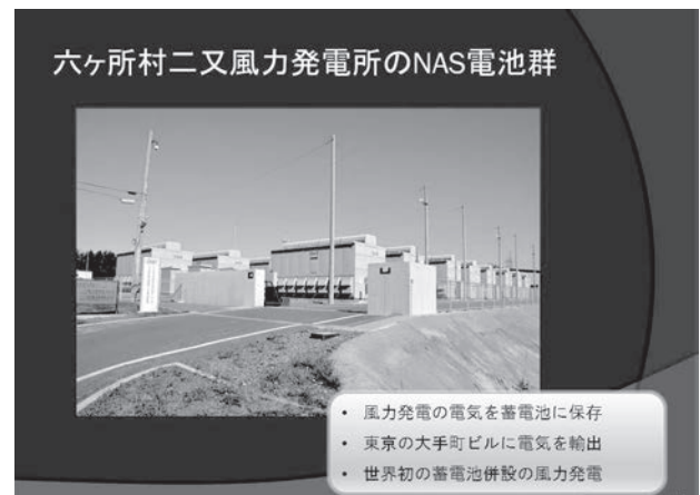
図4 六ヶ所村二又風力発電所のNAS電池
