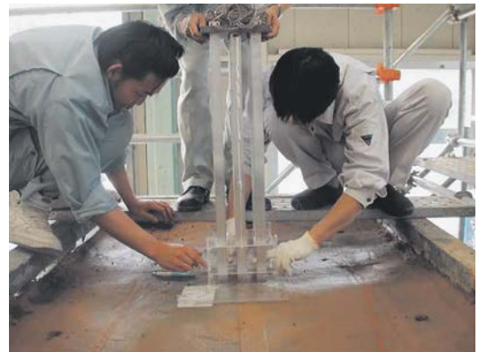
写真-4 群杭模型設置状況
