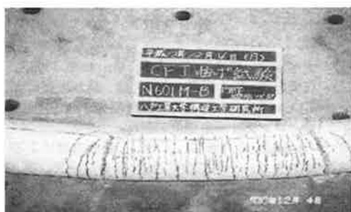
図-25 N60LM-Bの充填コンクリートの破壊
