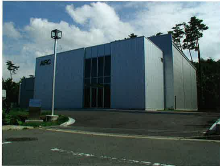
図 5.17: 八戸地域研究所 未来技術研究棟
