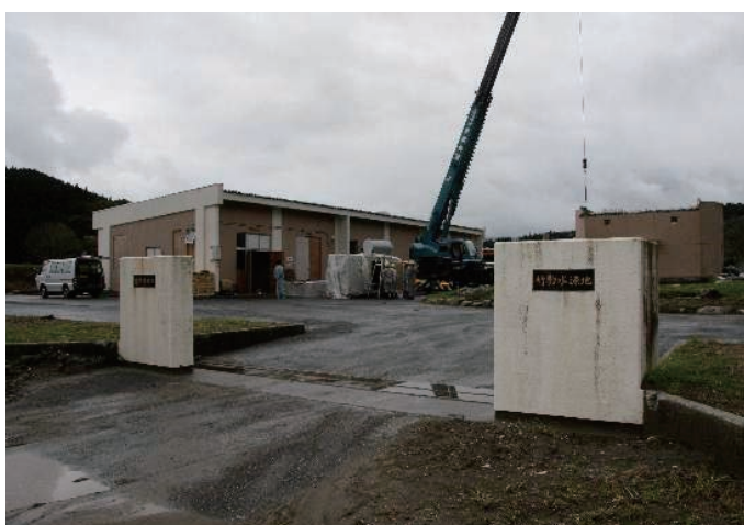
写真1 津波により浸水した陸前高田市竹駒水源
