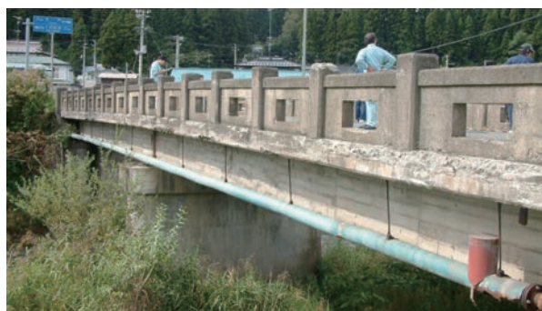
既存橋梁の耐久性調査
