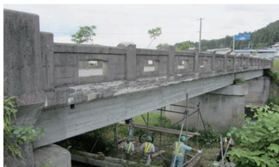
老朽化した橋梁の調査
