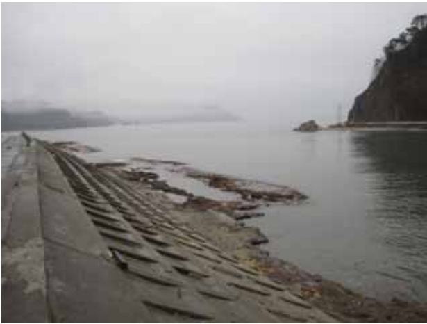
写真3.4.5.8 鵜住居川右岸導流堤の様子
