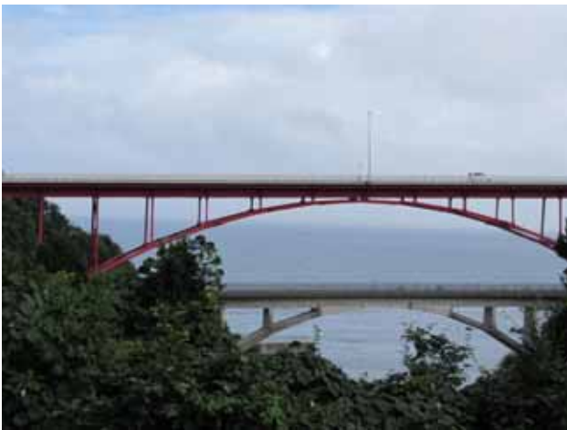
写真 4-2-2-8 掘内大橋 (普代村)
