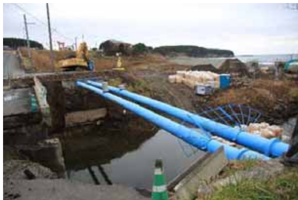
写真6-1-2 洋野町 大浜橋水管橋
