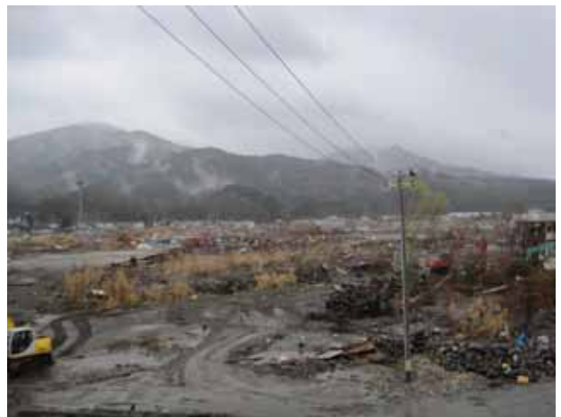
写真 3.4.9.12 津軽石川右岸地区の被災状況
