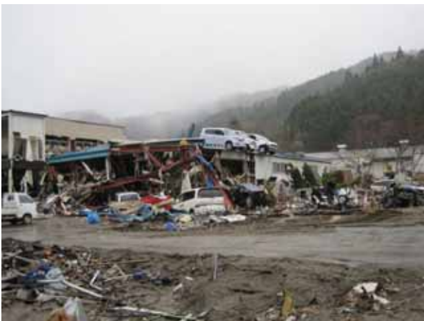
写真 3.4.2.11 熊野川右岸家屋の被災状況
