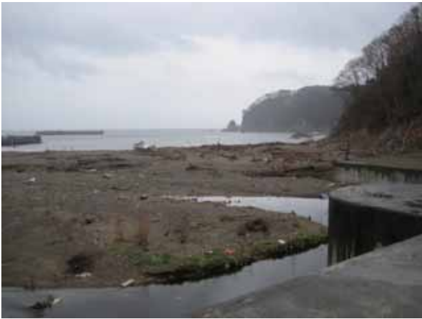
写真 3. 4. 10. 2 熊野川河口右岸の家屋被災状況
