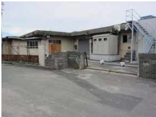
写真6-1-5 山田町 山田浄水場（水源）
