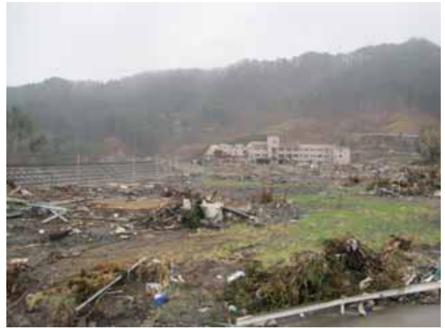
写真 3.4.2.6 熊野川右岸防潮堤背後の校舎周辺の家屋被災
