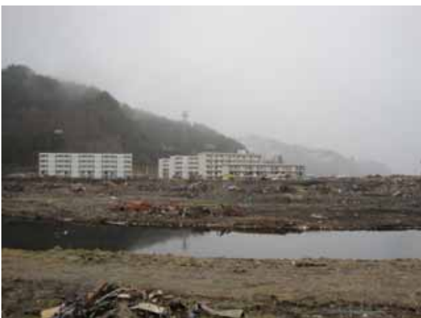
写真3.4.5.4 鵜住居川と右岸街区の壊滅と残っている校舎
