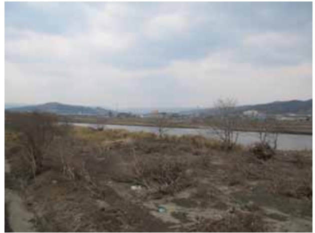
写真 3.4.17.5 久慈川右岸、河畔林被災状況
