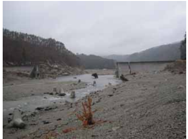
写真3.4.12.6 摂待川河口から大破した防潮堤をみる
