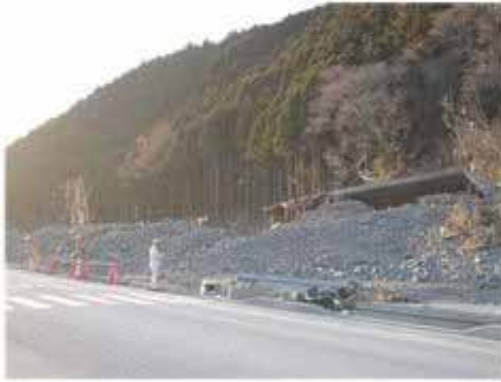
図4-2-24 津波による盛土・駅設備流出，擁壁倒壊（気仙沼線陸前戸倉駅） 14)
