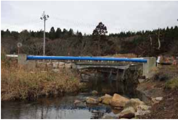
写真6-1-1 洋野町 和座橋水管橋
