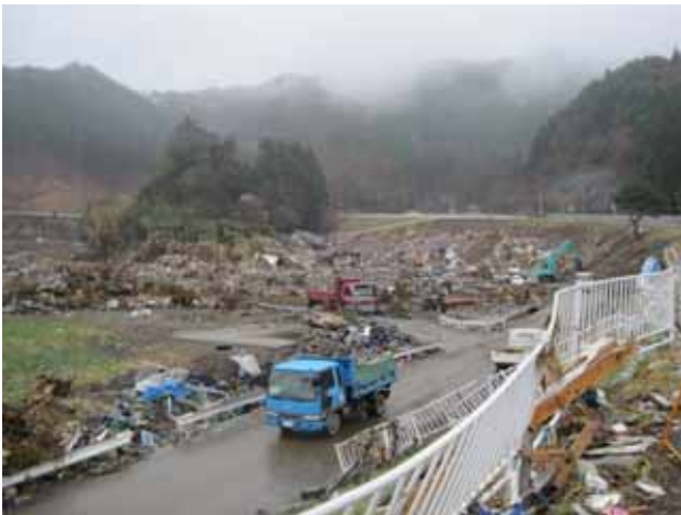
写真 3.4.2.4 熊野川右岸防潮堤と国道45号線間の家屋被災状況
