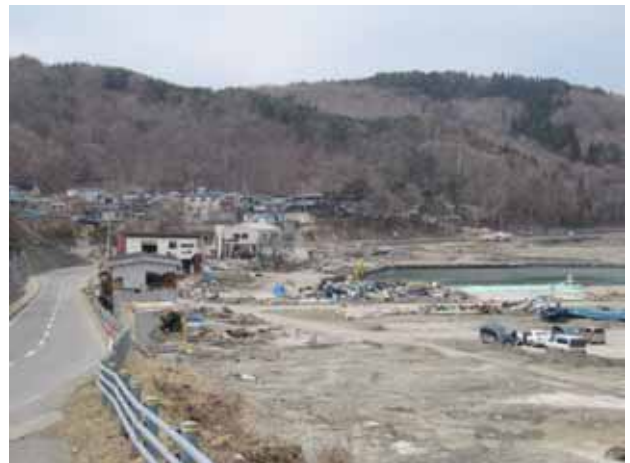
写真3.4.17.1 久慈川右岸南久慈漁港の被災状況
