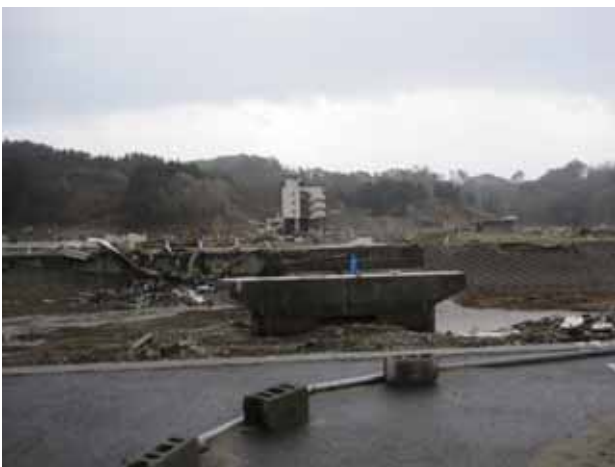
写真3.4.11.16 長内川左岸。流失した橋。
