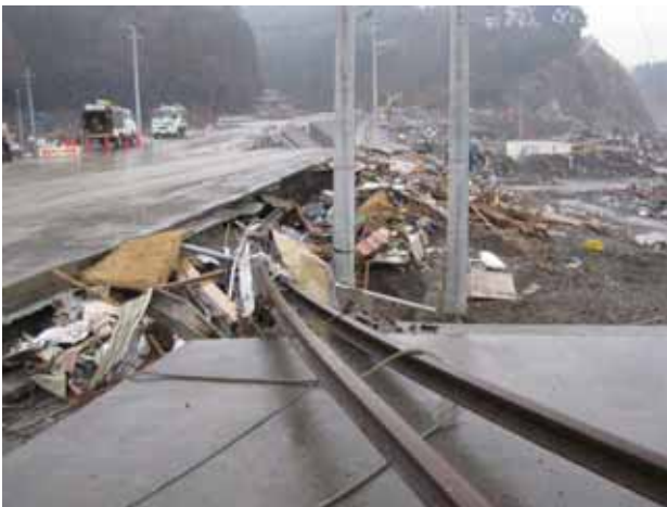
写真3.4.7.9 小槌川左岸街区の被災状況と漂流転動してきた鉄道レール
