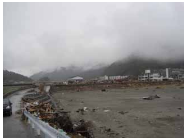
写真3.4.5.6 鵜住居川左岸河口から上流の様子。家屋、街の被災状況
