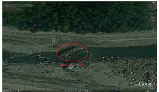
写真3.4.12.18 Googleより。津波来襲後の摂待川。670m運ばれた重さ514トンのコンクリート塊
