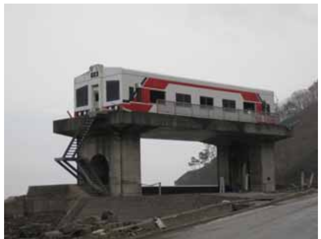
写真 3.4.13.6 平井賀川河口防潮水門
