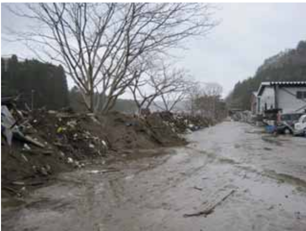
写真 3. 4. 10. 4 田老川（田代川）右岸堤防背後の家屋の被災状況および津波が道路に堆積させた砂
