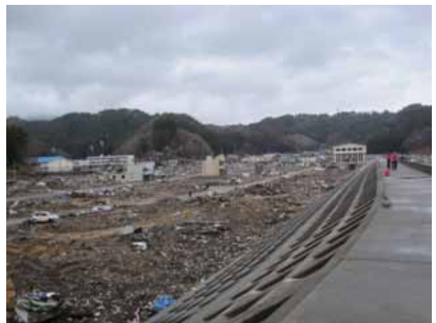
写真3.4.11.7 長内川左岸堤防、下流から上流側を見る
