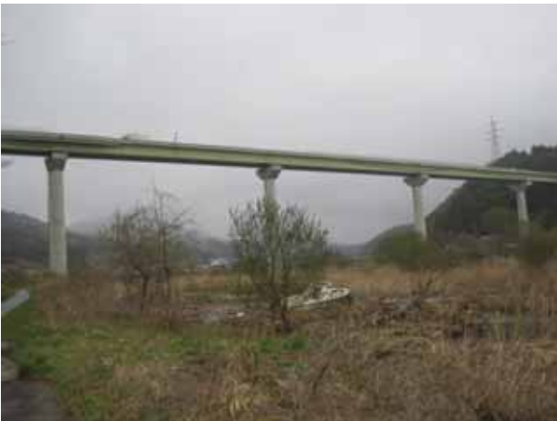
写真3.4.1.2 盛川津波遡上点から三陸自動車
