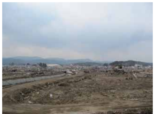
写真 3. 4. 16. 7 宇部川右岸、泉沢川左岸市街地の被災状況。
