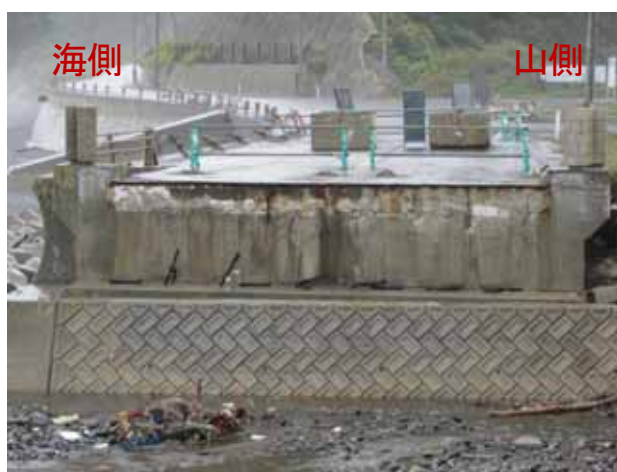
写真 4-2-2-16 橋台部 (広内橋: 野田村)
