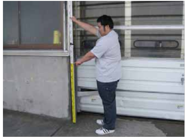
写真 3.3.4.4 岩谷漁港、漁協荷捌施設の津波遡上高。津波；2.02m（TP）。
