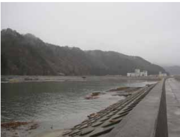
写真 3.4.5.10 鵜住居川右岸導流堤
