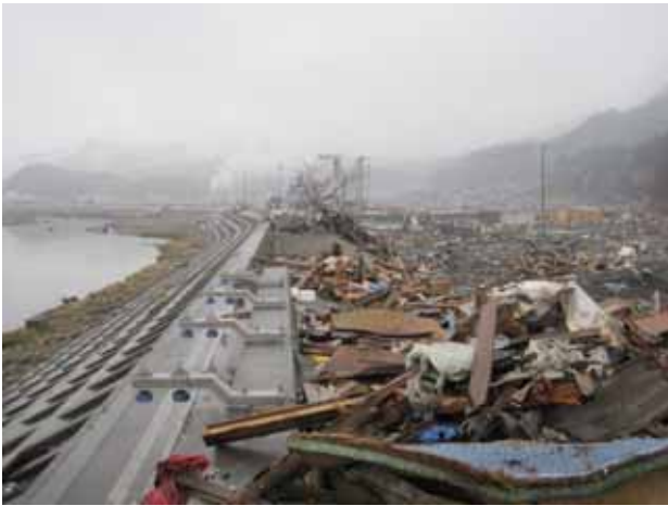
写真3.4.7.8 小槌川左岸背後の家屋被災状況
