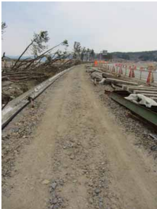
写真4-3-3-11 線路の流出（野田村）
