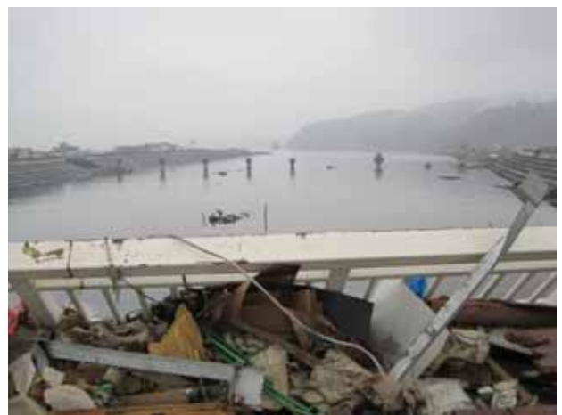
写真3.4.7.7 小槌川 消失した鉄道橋と河口の様子
