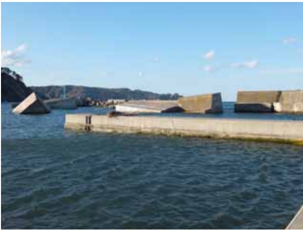
図4-4-5 転倒したゲートソン（田野畑村島越漁港）
