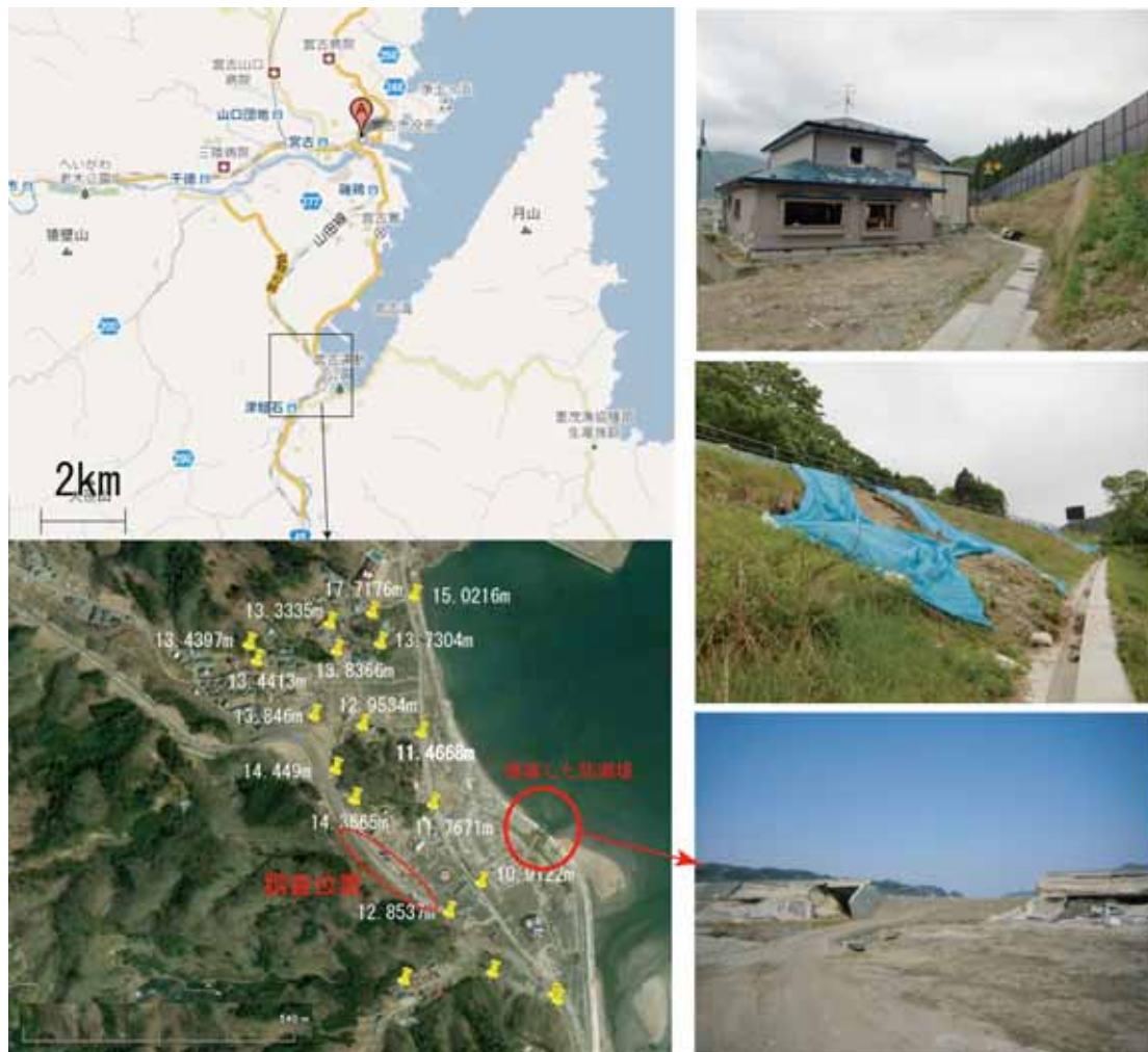
図 4-3-6 岩手県宮古市金浜地区の補強土壁の状況
