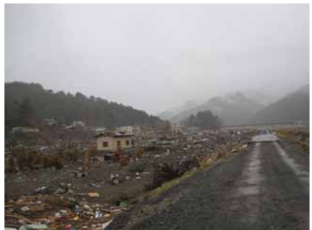
写真 3.4.5.1 鵜住居川右岸街区の被災状況
