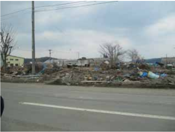
写真 3.4.17.8 久慈川河口部右岸地区の被災状況。
