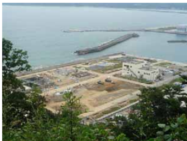
写真 6-3-6 地上設備の復旧 8/31 撮影
