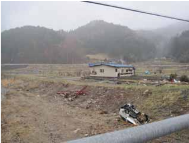
写真 3.4.3.2 片岸川右岸街区の大破状況
