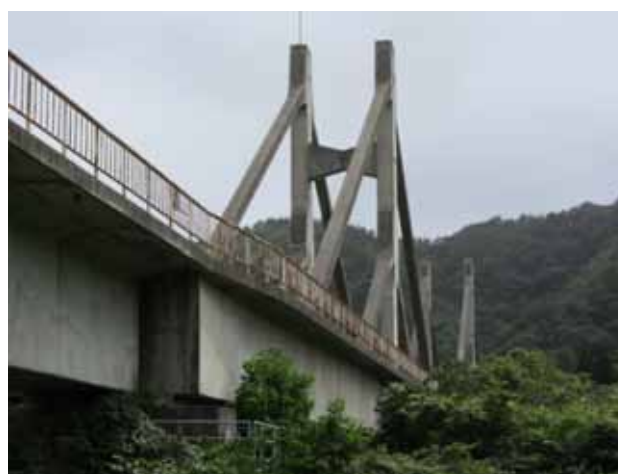
写真 4-3-3-15 小本川橋梁（岩泉町）
