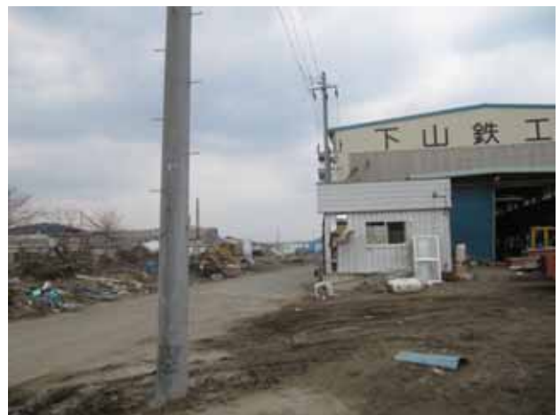
写真 3.4.17.7 久慈川河口部右岸、工場の被災状況。
