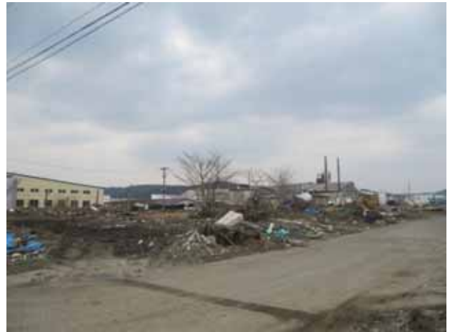
写真 3.4.17.6 久慈川河口部右岸、工場の被災状況。
