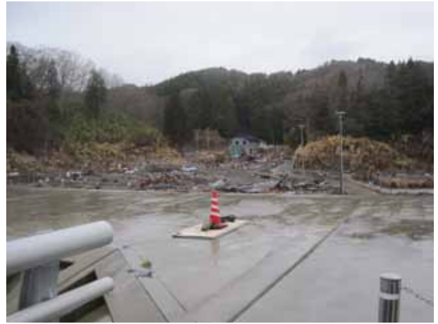
写真 3.4.9.6 津軽石川河口防潮水門付近右岸の家屋被災状況、家屋は大破流失。
