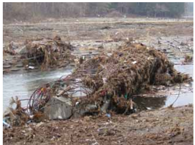
写真3.4.12.7 上流に運ばれた摂待川防潮堤水門コンクリート塊
