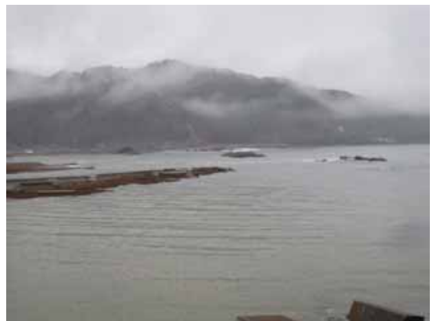
写真 3.4.5.12 鵜住居川河口の様子 防潮堤が大破し、コンクリート塊が散乱している
