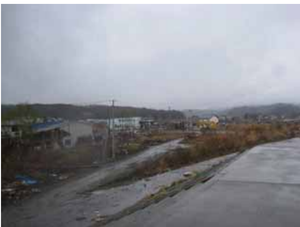
写真 3.4.9.10 津軽石川右岸家屋の被災状況
