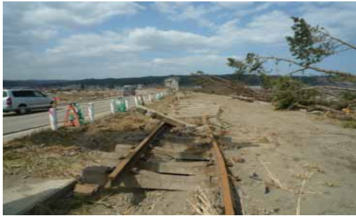
コンクリートの枕木ごと引きちぎられた三陸鉄道（野田村）
