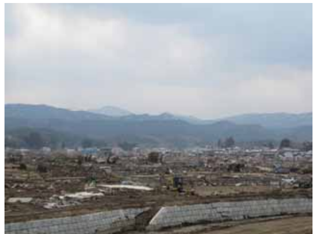
写真 3. 4. 16. 6 宇部川右岸南部、野田村市街地の被災状況。
