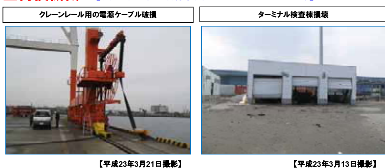
図 4-4-4 係留施設、護岸、荷役機械、上屋の被害
