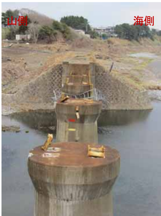
写真 4-3-2-2 橋脚 (大浜川橋梁)
