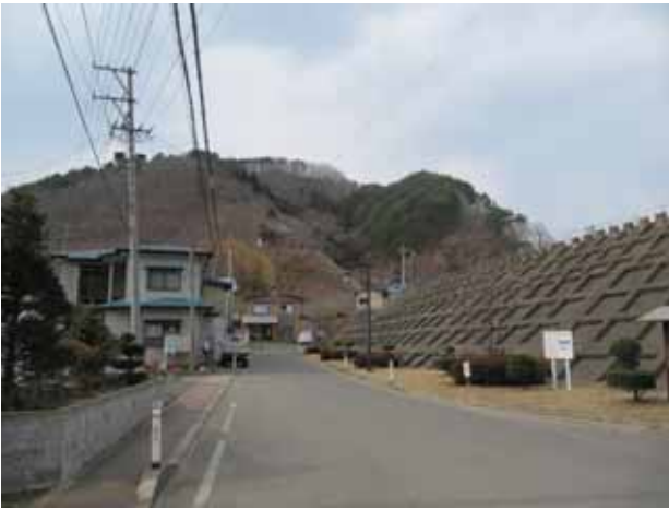
写真 3.4.15.8 普代川右岸大田名部地区の防潮堤、完全に津波から地区を守った。防潮堤天端高 15.5 m。
