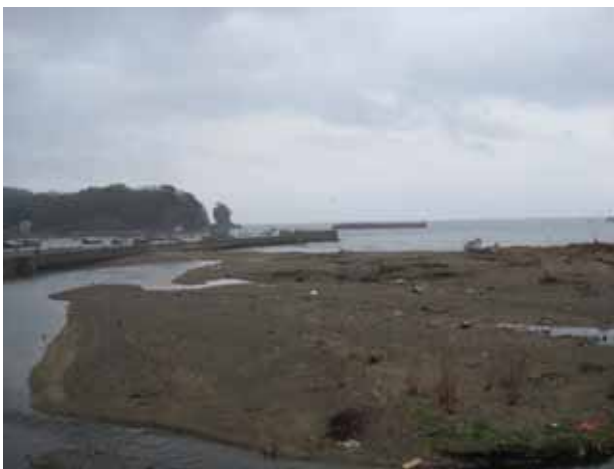
写真3.3.10.9 田老川（田代川）右岸河口の様子
