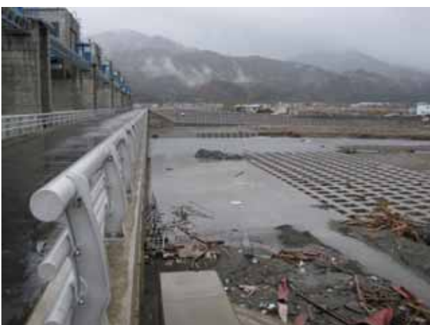
写真 3.4.9.4 津軽石川防潮水門上流側の様子
