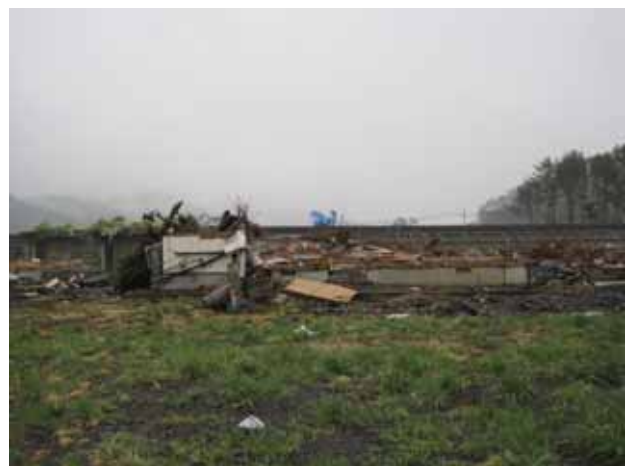
写真 3. 4. 2. 20 熊野川右岸家屋被災状況
