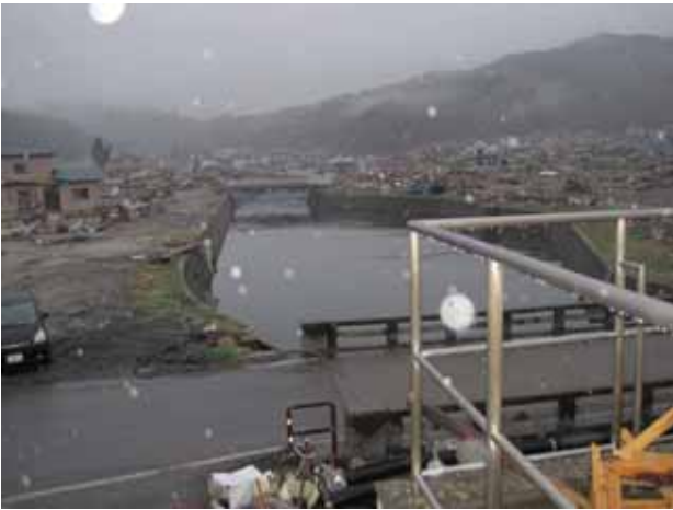
写真 3.4.8.2 大沢川兩岸の被災状況。河口から上流をみる。
