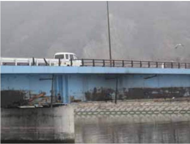
写真3.4.1.7 盛川左岸から最下流地点の橋および右岸を望む
