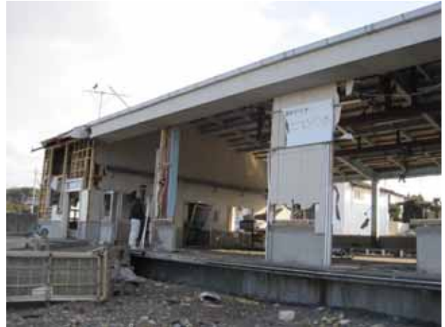
写真 3.3.1.7 階上町大蛇漁港上海産物簡易加工処理センター。津波 9.71m (TP)
