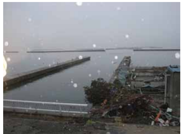
写真 3.4.8.1 大沢川河口周辺の被災状況
