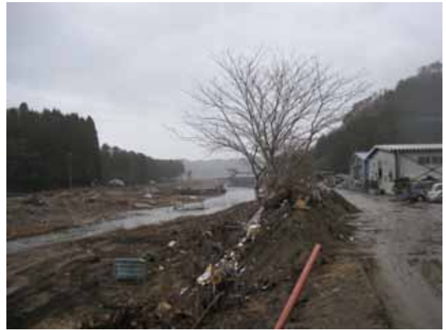
写真3. 4. 10. 5 田老川（田代川）上流国道下右岸の被災状況
