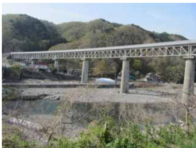
写真4-3-3-13 安家川橋梁（野田村）
