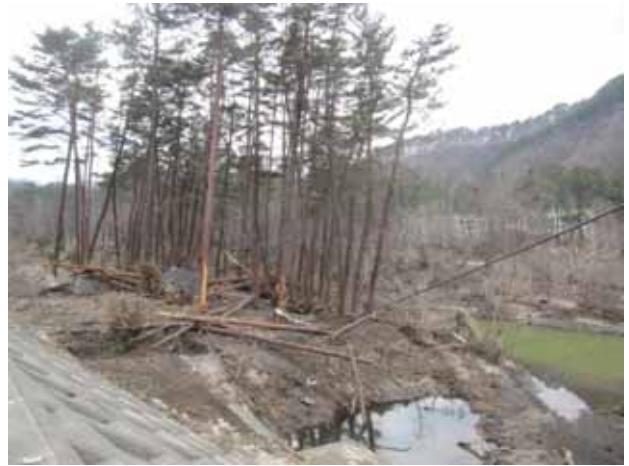
写真 3.4.15.5 普代川右岸、水門上流の河畔林被災状況
