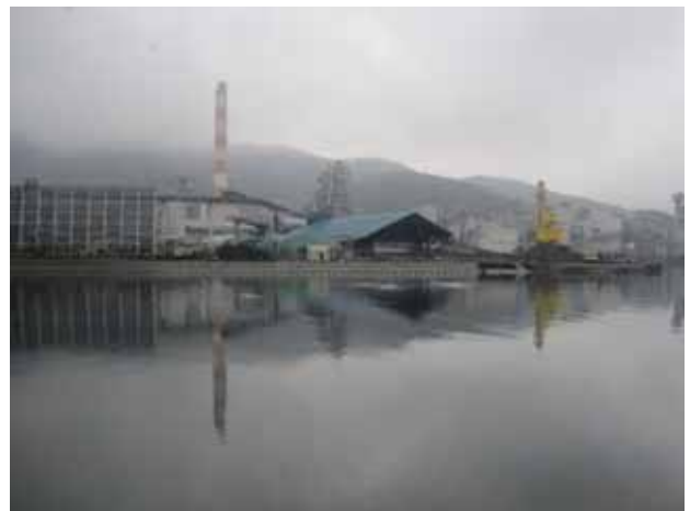
写真3.4.1.12 盛川河口付近の左岸被災状況
