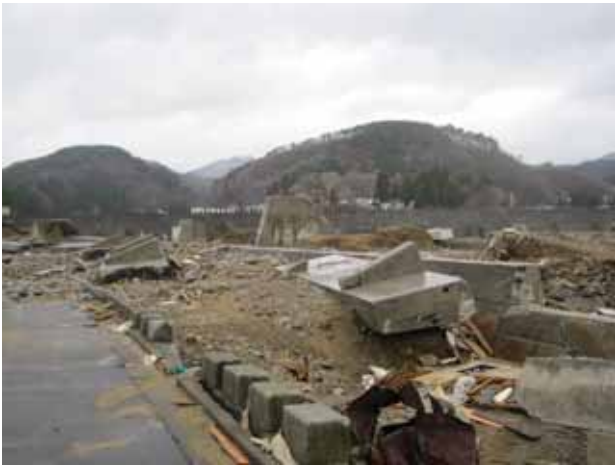
写真 3.4.11.3 長内川右岸被災状況
