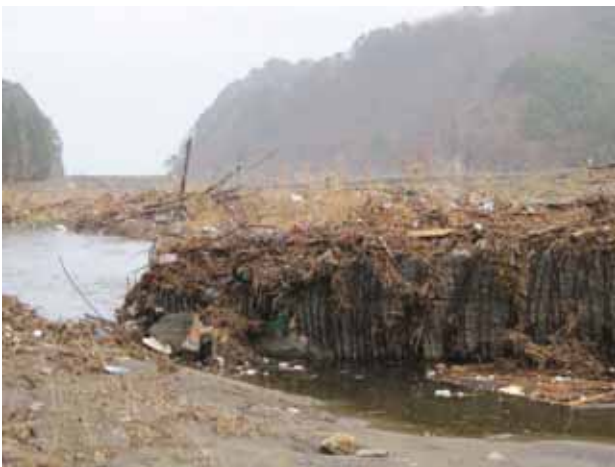
写真3.4.12.9 摂待川右岸。津波の輸送距離670m.
