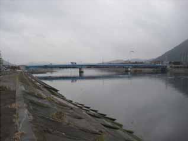
写真 3.4.1.13 盛川河口右岸の表法面の被災状況
