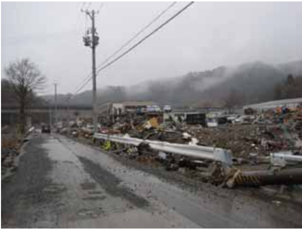
写真 3.4.2.9 熊野川右岸家屋の被災状況
