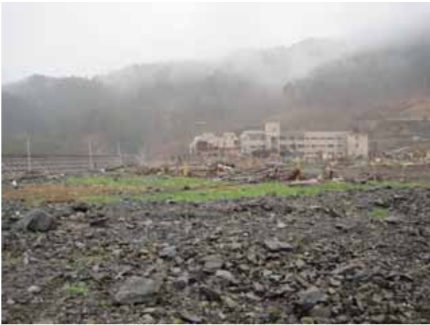
写真3.4.2.21 熊野川右岸防潮堤背後の街区被災状況
