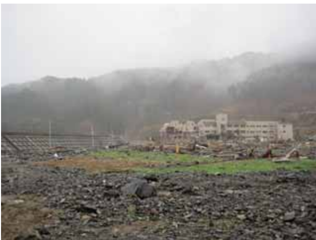
写真 3.4.2.10 熊野川右岸防潮堤裏の校舎
