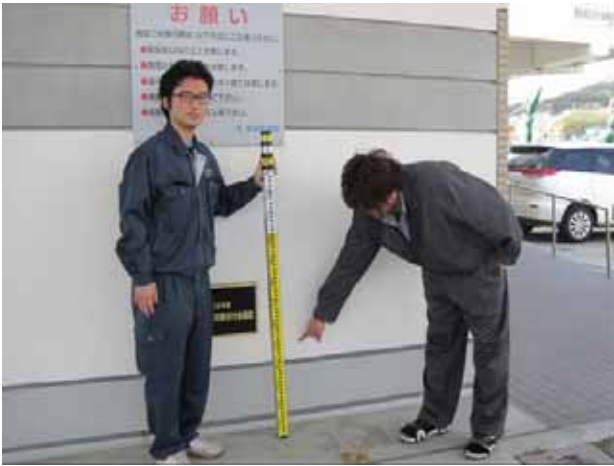
写真 3.3.4.1 白糠漁港（焼山地区、六ヶ所村）における津波遡上高。津波；2.18m（TP）。
