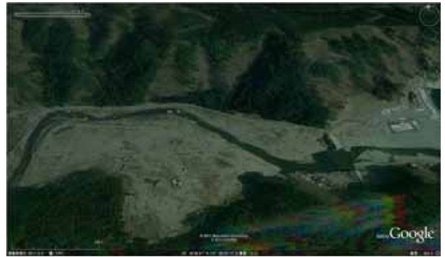
写真3.4.12.17 Googleより。津波来襲後の摂待川防潮堤水門（河道部コンクリート部が消失。）
