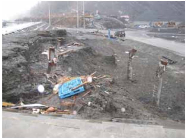
写真 3.4.6.5 大槌川左岸堤防背後の家屋および街区の大破被災状況
