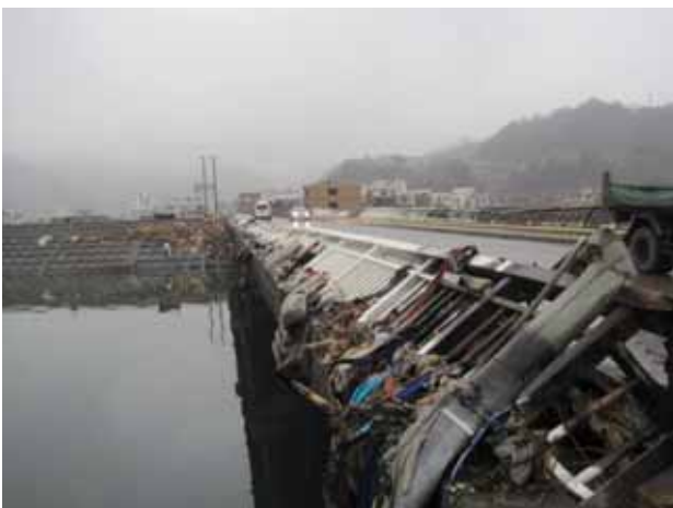
写真 3.4.7.10 小槌川左岸から橋と大破した街の被災状況
