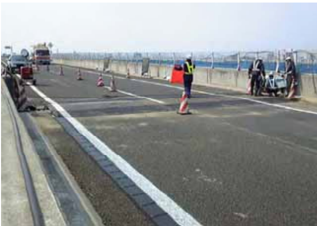
写真4-2-1-5 応急復旧の状況② (仙台東部道路：NEXCO東日本 提供)
