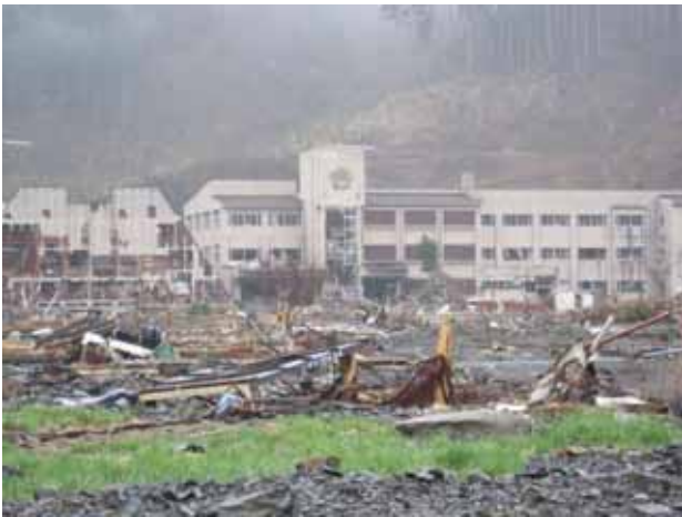
写真3.4.2.22 熊野川右岸防潮堤背後の校舎付近の家屋被災状況
