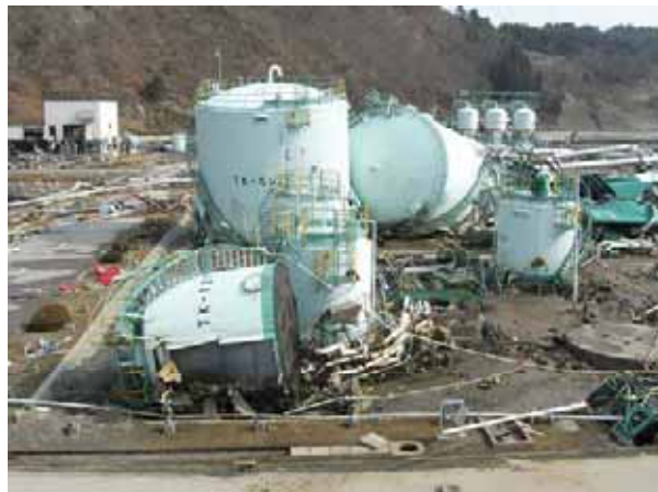
写真 6-3-6 地上施設の被災状況 提供：久慈国家石油備蓄基地
