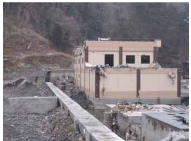
写真 3. 4. 13. 13 平井賀川左岸、木造家屋大破、流失。コンクリート家屋残る。
