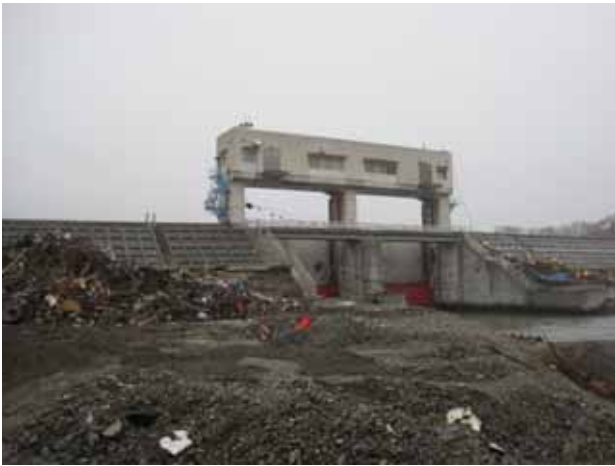
写真 3.4.4.2 水海川防潮堤および水門
