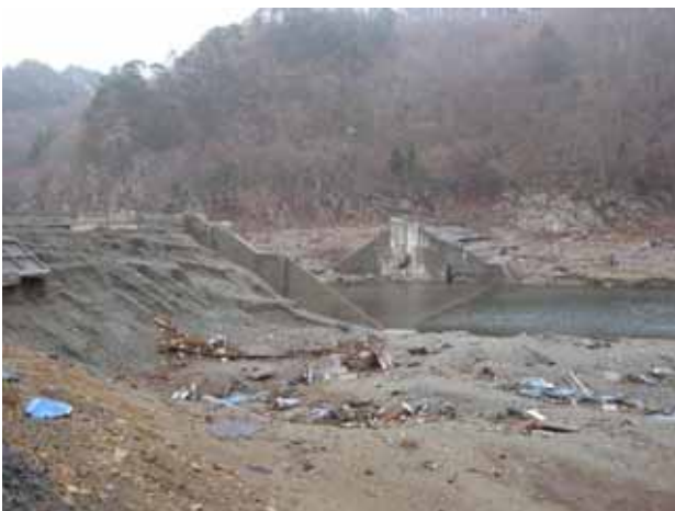
写真3.4.12.10 摂待川右岸防潮堤裏法面
