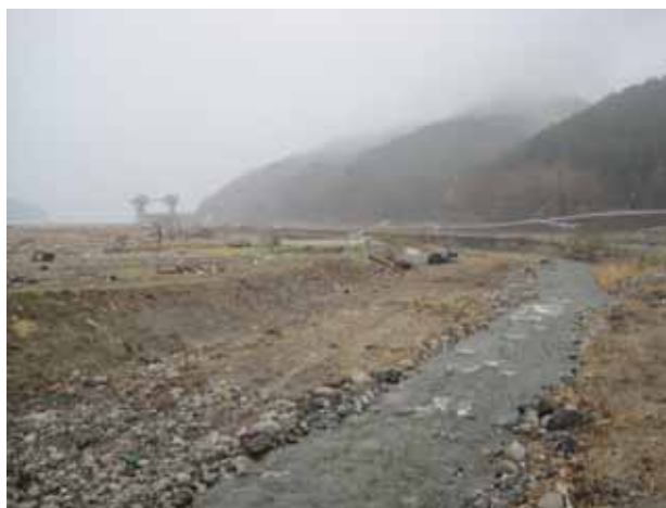
写真 3.4.3.1 片岸川左岸街区の大破状況
