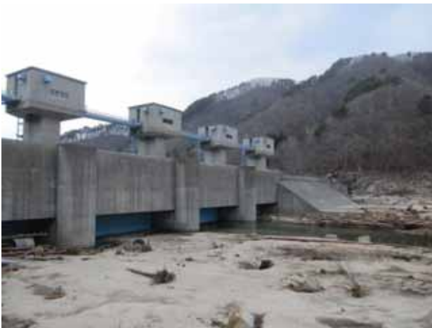
写真 3.4.15.3 普代川防潮堤水門河口側の様子。 防潮堤天端高 15.5m
