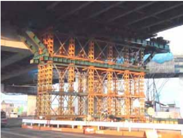
写真4-2-1-4 応急復旧の状況① (仙台東部道路：NEXCO東日本 提供)
