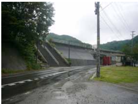
図4-2-17 被害が無い防潮堤（普代村大田名部水門）
