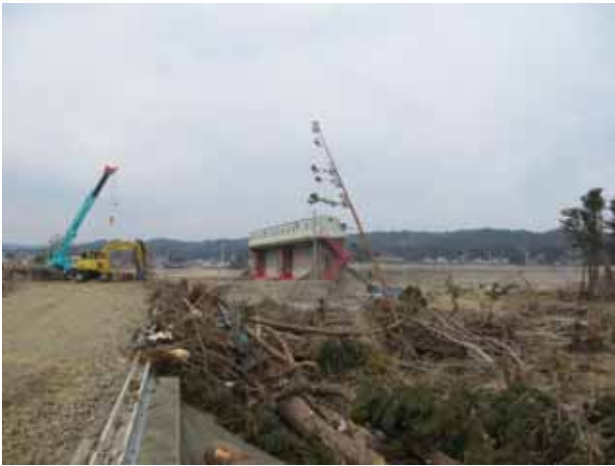
写真 3. 4. 16. 2 宇部川右岸、防潮林の壊滅状況
