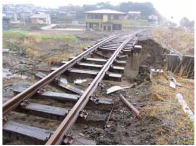
写真 4-3-2-4 線路の状況 (八木川橋梁)
