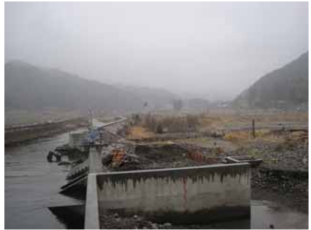
写真 3.4.3.5 片岸川河口付近街区の被災状況（街が大破）
