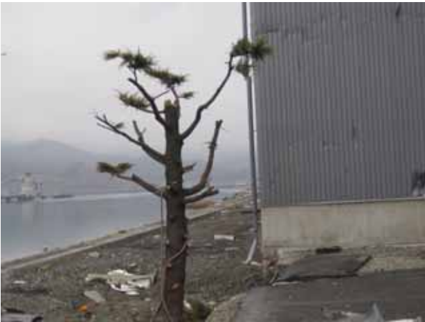
写真 3.4.1.14 盛川河口近くの左岸被災状況
