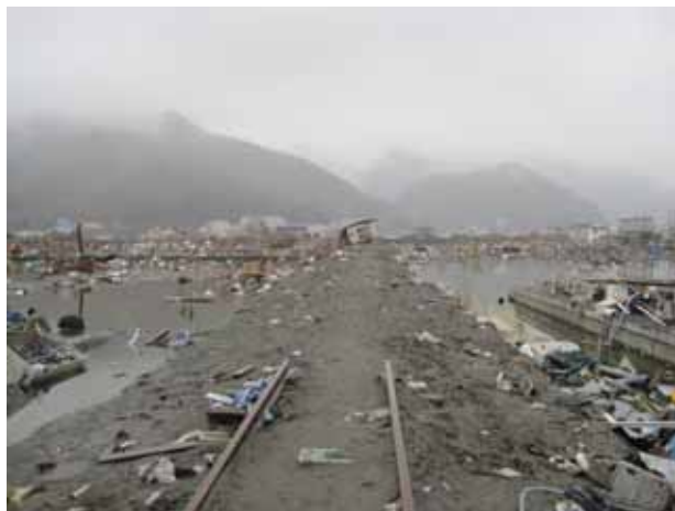
写真 3.4.7.1 小槌川左岸の鉄道施設の被災状況
