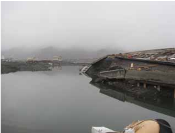
写真 3. 4. 6. 9 大槌川防潮堤水門の上流の被災状況
