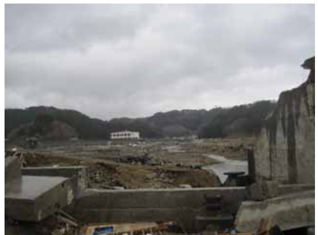
写真3.4.11.13 長内川左岸の被災状況。防潮堤があつたが津波により消失。
