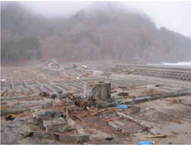
写真 3.4.14.2 明戸川左岸被災状況
