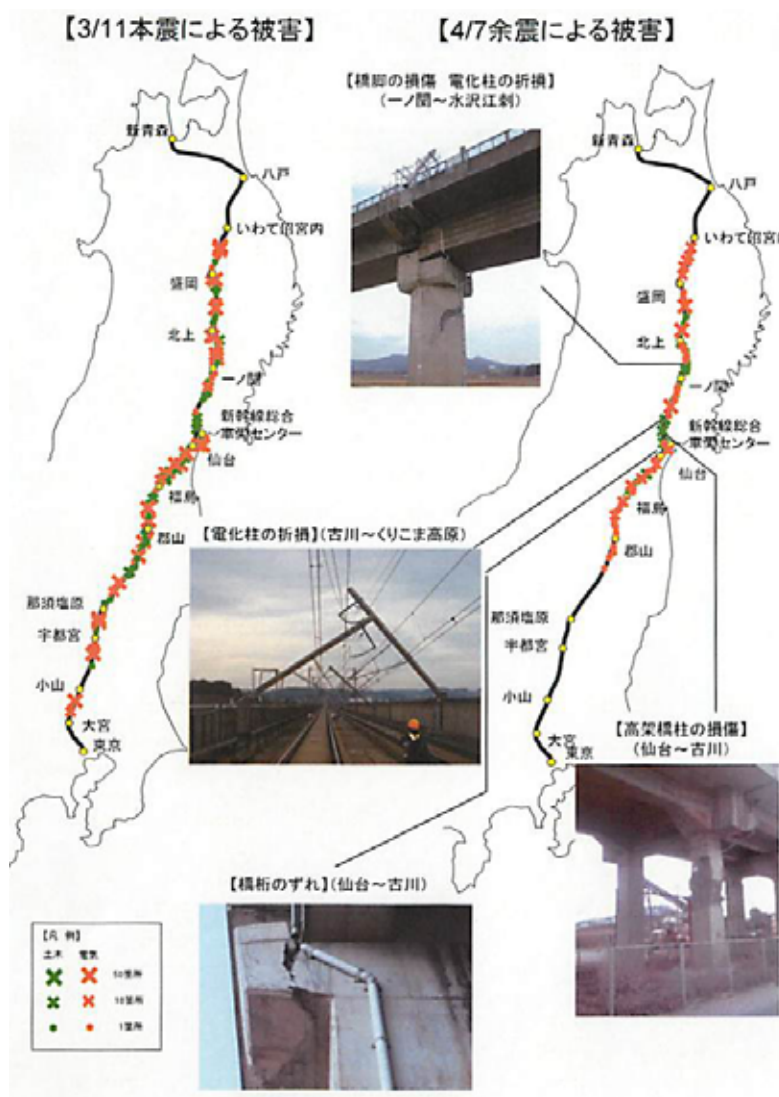
図 4-3-1-1 東北新幹線の被害状況 (4/17現在: JR東日本HPより)
