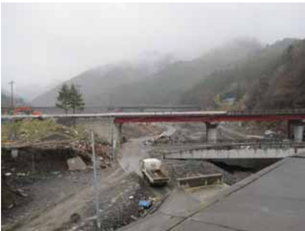
写真 3. 4. 2. 17 熊野川国道 4 5 号線橋付近海側の被災状況
