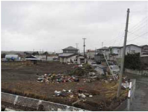
写真 3.3.3.4 奥入瀬川左岸、堤防背後の民家の津波被災状況。越流した津波は1.86mで民家を襲っている。津波は7.86m (TP) である。
