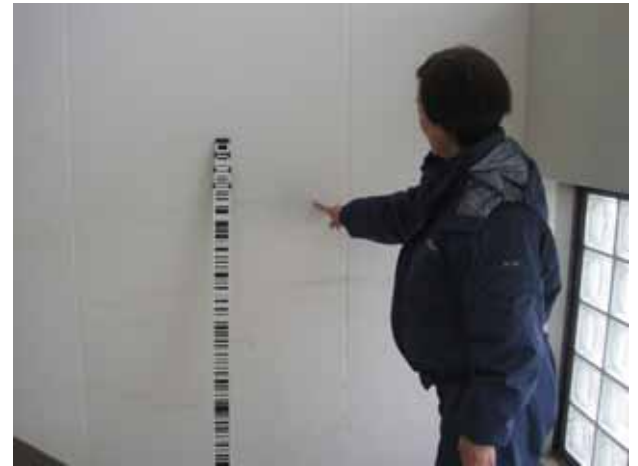
写真 3.3.3.17 三沢漁港内の研修センター館内の壁に残っている津波痕跡を指さして教えてくれている漁協職員。津波 ; 6.81m (TP)。
