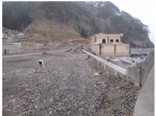
写真 3. 4. 13. 12 平井賀川左岸街区消失
