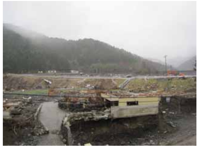
写真 3. 4. 2. 18 熊野川右岸防潮堤背後の家屋被災状況
