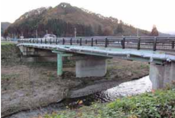
写真6-1-3 宮古市田老地区 橋梁添加管および大平浄水場
