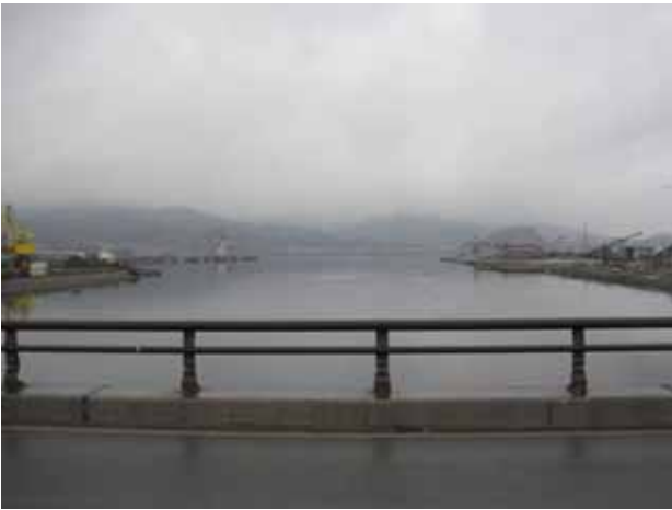
写真3.4.1.19 盛川河口橋から河口の様子
