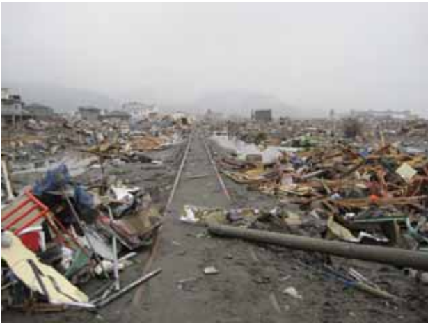
写真 3.4.7.2 小槌川左岸の鉄道施設および街区の被災状況
