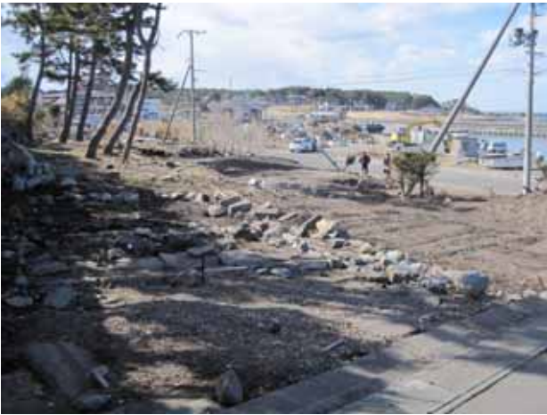
写真 3.3.1.4 階上町大蛇小学校下南地域 津波 8.44m (TP) (海側にある海岸護岸堤防を約1.8mの越流水深で遡上してきた被災地)
