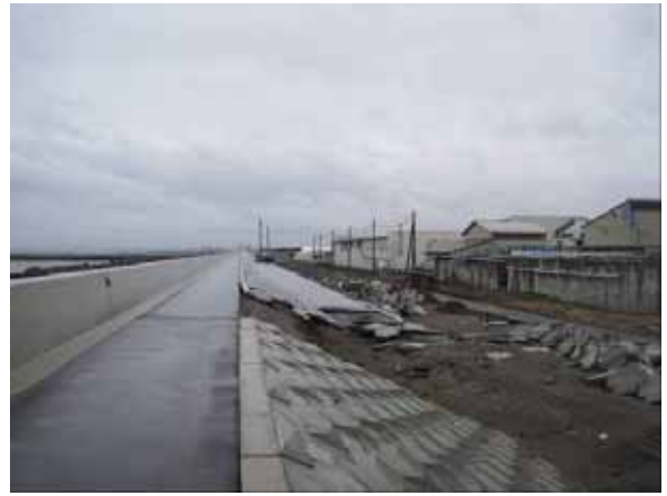
写真 3.3.3.7 おいらせ町松原地区の被災状況を示す。越流水深 1.21m、天端高 7.5m より、津波を 8.71m (TP) とした。
