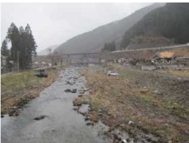
写真3.4.3.4 片岸川沿いの被災状況、被害は大きい。
