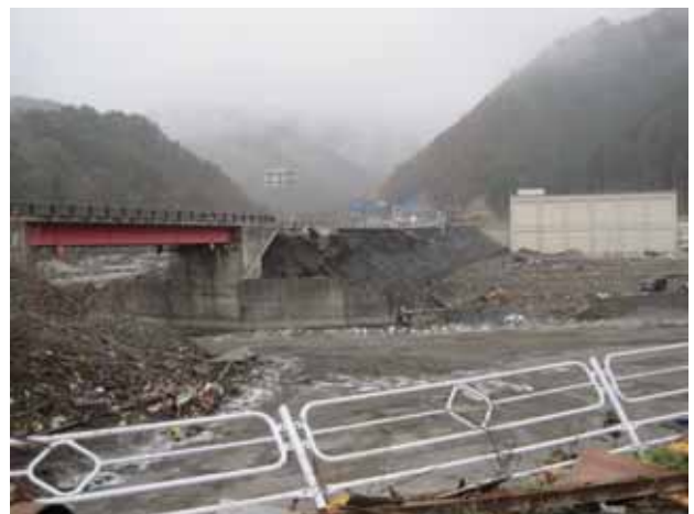
写真 3.4.4.6 水海川左岸国道の陸側、国道および家屋の被災状況
