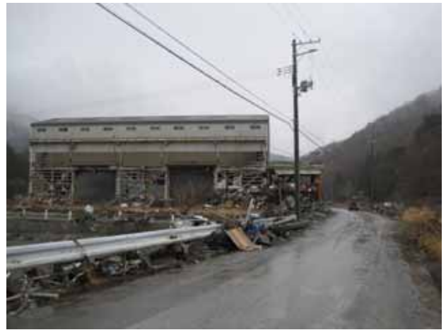
写真 3.4.2.8 熊野川右岸家屋の被災状況
