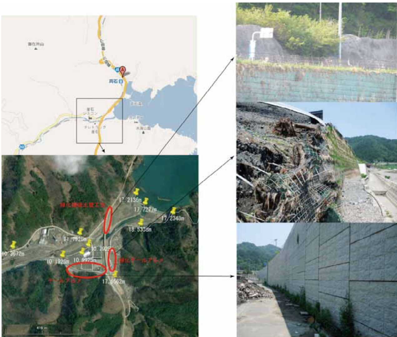
図 4-3-4 岩手県釜石市両石地区の補強土壁の状況
