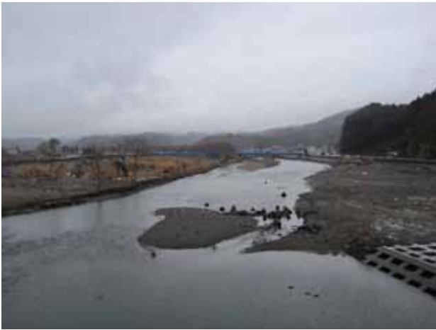
写真 3.4.9.8 津軽石川防潮水門右岸から上流の様子
