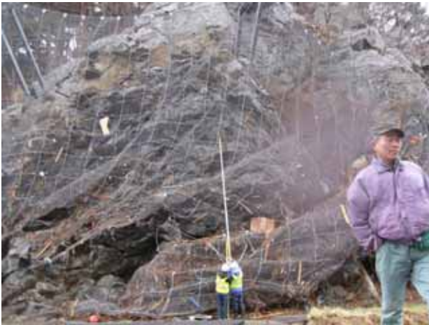
写真 3.4.12.3 摂待川右岸津波痕跡線高調査。津波高 28m (TP)
