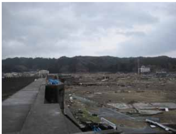
写真 3.4.11.1 長内川右岸防潮堤と消えた左岸防潮堤（写真中央）
