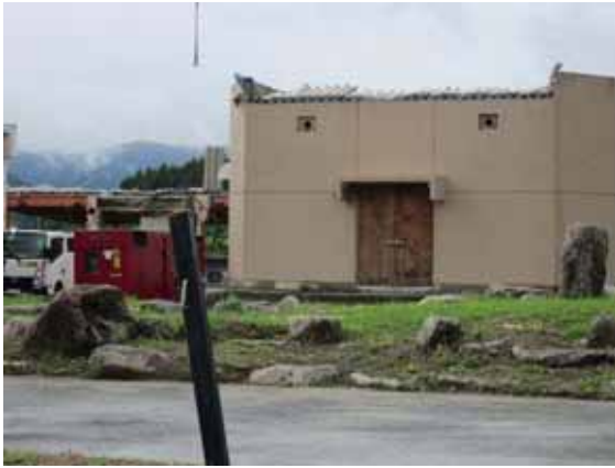
写真6-1-9 陸前高田市 竹駒第1水源地
