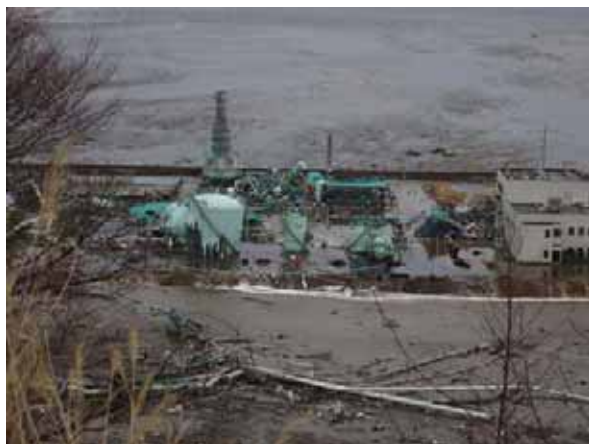
写真 6-3-6 津波の到来 避難場所から撮影 提供：久慈国家石油備蓄基地
