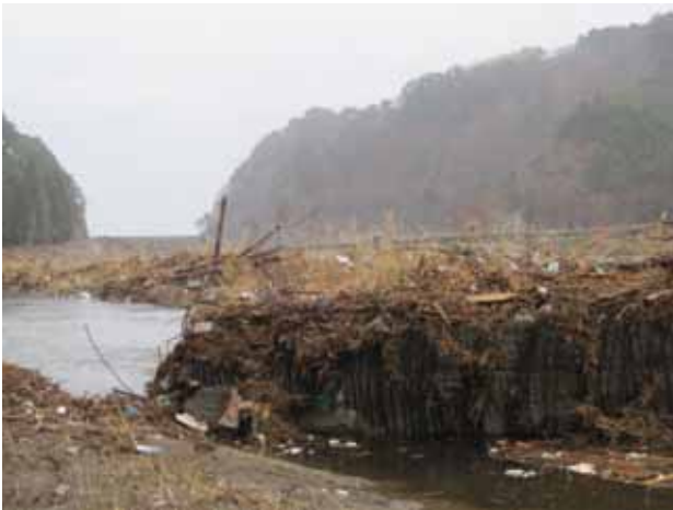
写真3.4.12.8 摂待川右岸。コンクリート固まり 長さ：11.0m 4.5m 高さ：4m 重さ：514トン。
