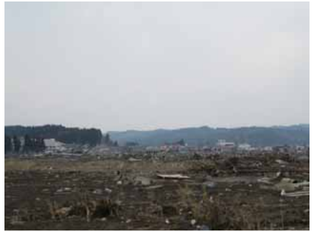
写真 3. 4. 16. 5 宇部川右岸、泉沢川左岸市街地の被災状況
