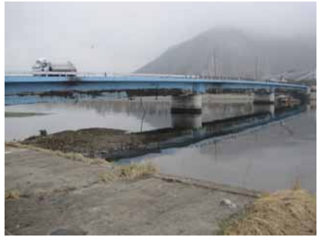
写真3.4.1.4 盛川右岸 最下流地点の橋
