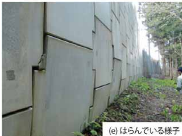
図 4-3-3 崩壊したテールアルメ (岩手県一関市)
