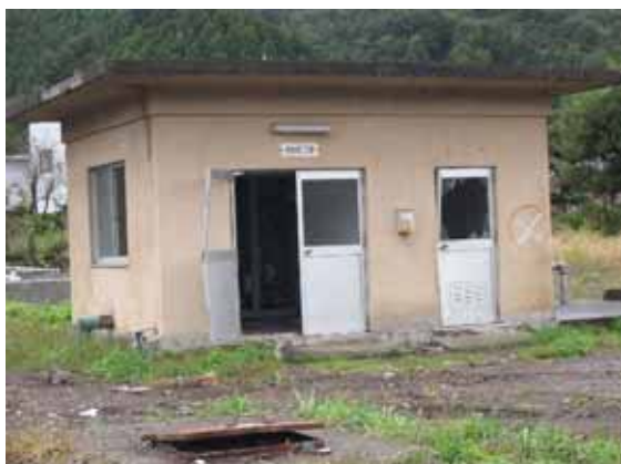
写真6-1-8 釜石市 平田ポンプ場
