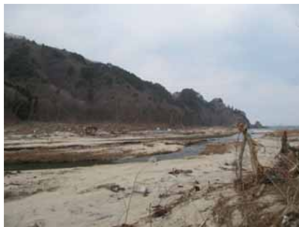
写真3.4.15.1 普代川河口の河畔林の被災状況
