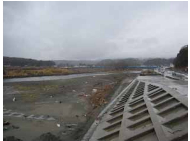
写真 3.4.9.5 津軽石川防潮水門から上流右岸の様子
