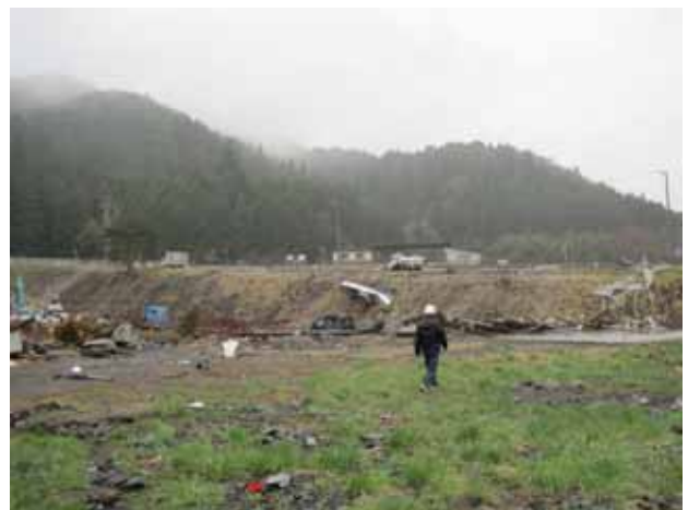
写真 3. 4. 2. 19 熊野川右岸家屋被災状況
