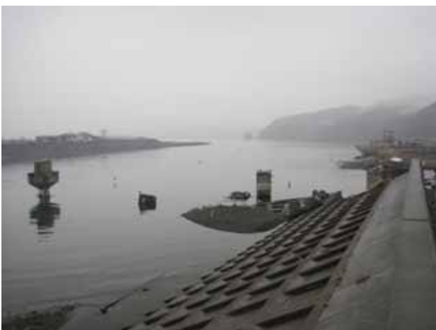
写真3.4.7.4 小槌川鉄道橋の被災状況。橋桁は吹き飛び、橋脚だけが残っている。
