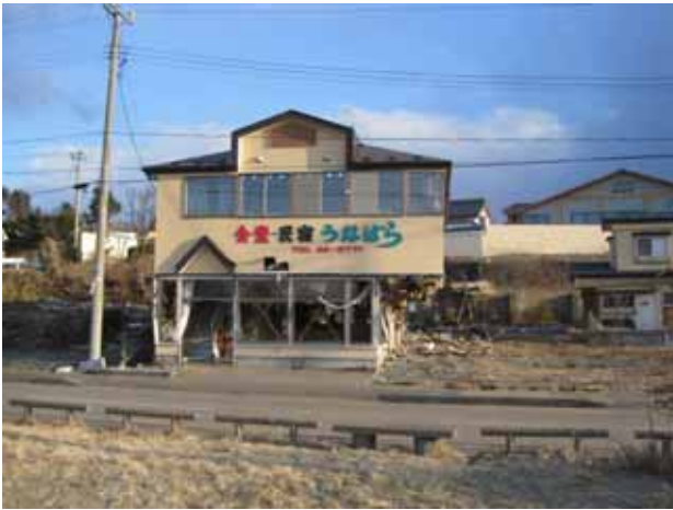
写真 3.3.2.7 白浜地区の食堂民宿うなばらの被災状況。地盤高約6m、津波痕跡線は建物の壁にあり、その高さは9.72m (TP) m。
