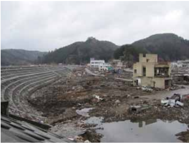
写真3.4.11.8 長内川左岸背後の街区被災状況
