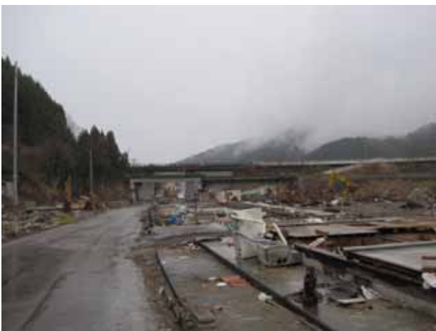
写真3.4.3.9 片岸川右岸家屋の被災状況
