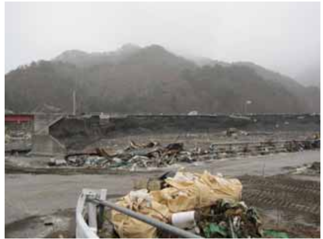
写真 3.4.4.5 水海川左岸国道の陸側、国道および家屋の被災状況
