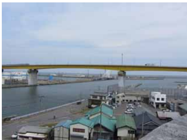
写真 4-2-2-13 八戸大橋 (八戸市)
