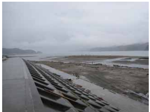
写真 3.4.9.1 津軽石川左岸河口の様子
