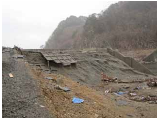
写真3.4.12.12 摂待川右岸裏法面被災状況
