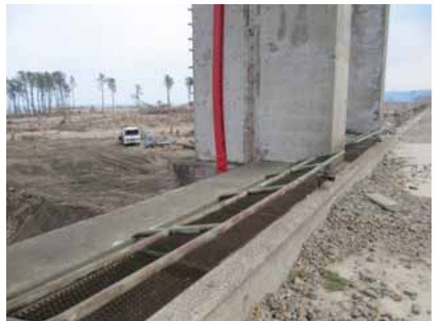
写真3.4.16.1 宇部川河口の河畔林の被災状況
