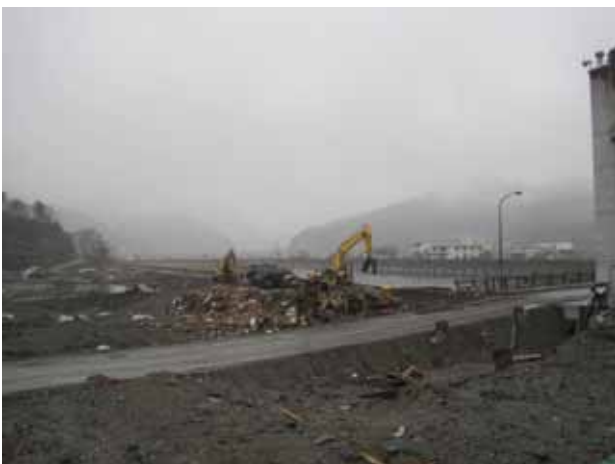
写真 3.4.6.4 大槌川右岸街区の全壊状況
