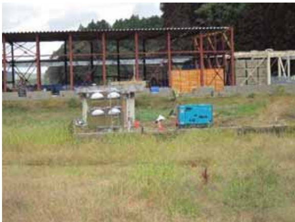
写真6-1-11 陸前高田市 長部水源地
