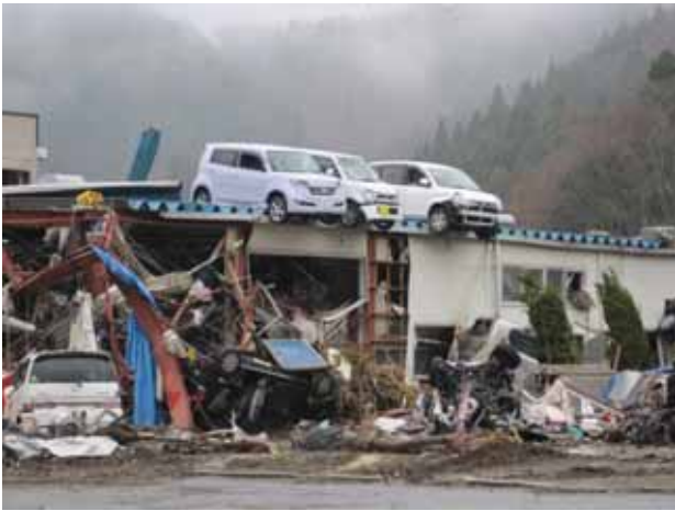
写真 3.4.2.3 熊野川右岸被災状況
