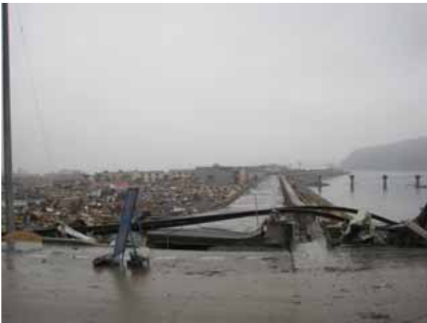
写真 3.4.7.3 小槌川左岸の被災状況
