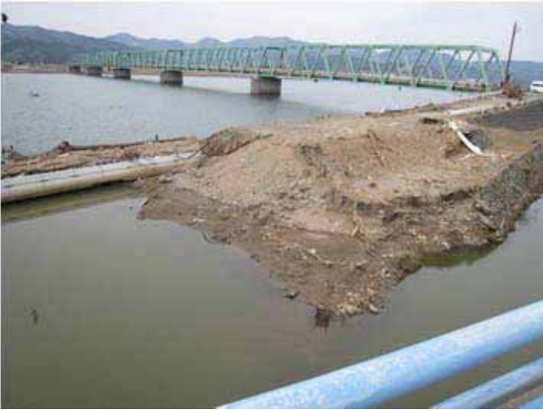
図4-2-6 津波による河川堤防の破堤（新北上右岸4.3km付近，新北上大橋上流部） 9)
