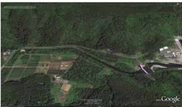
写真3.4.12.16 Googleより。津波来襲前の摂待川防潮堤水門（写真左の白い部分）
