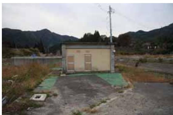
写真6-1-7 大槌町 波板ポンプ場および橋梁添加管
