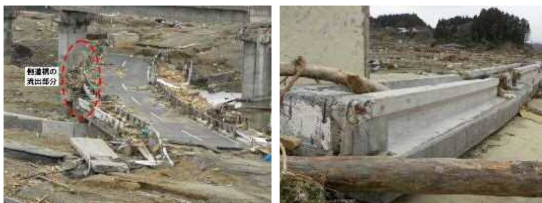
図 2.23 外尾川橋側道橋（下）の流失状況 4)
