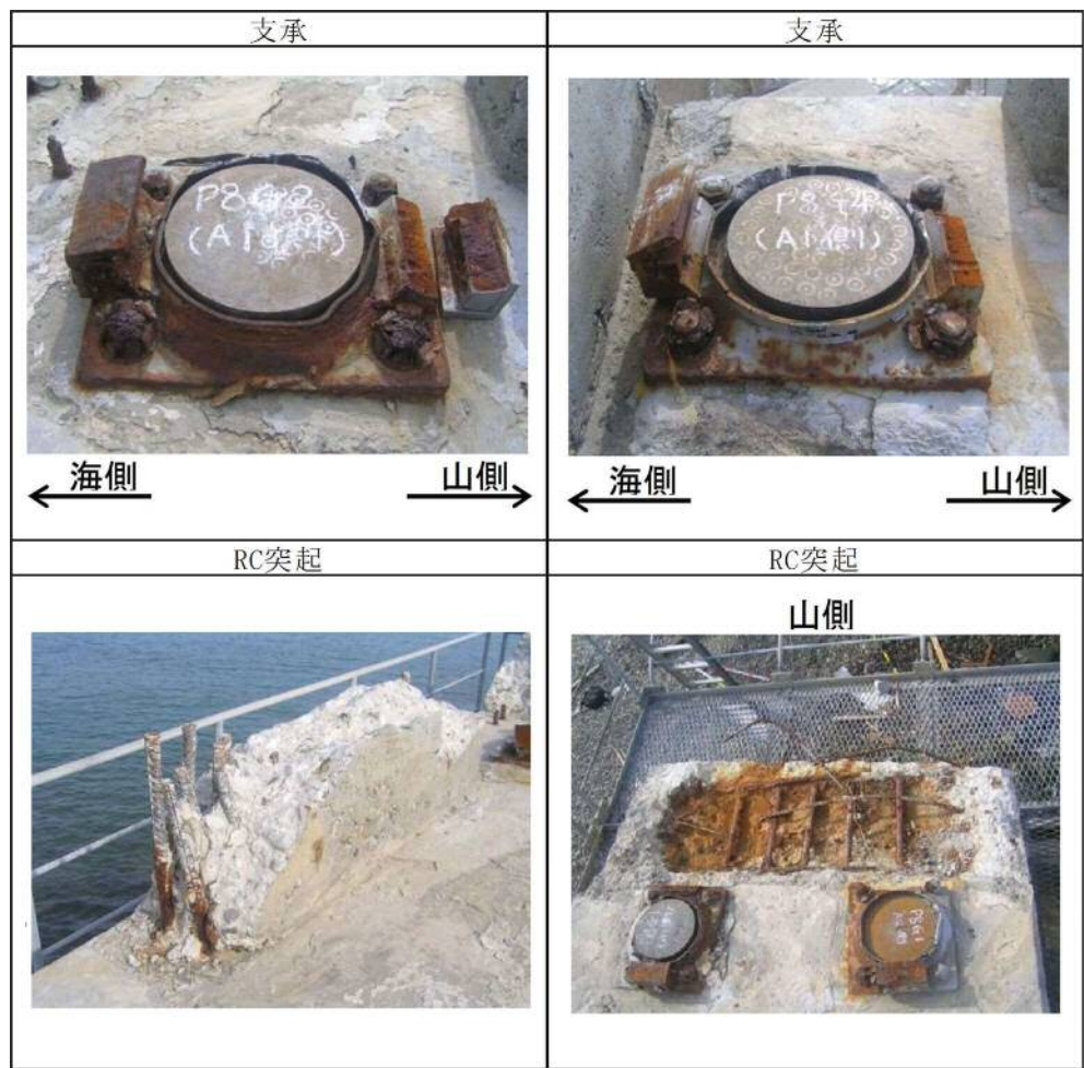
図 3.50 支承部損傷状況（歌津大橋） 【Span9】
