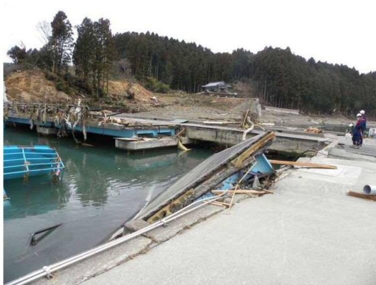
図 2.19 水尻橋の流失状況 4)
