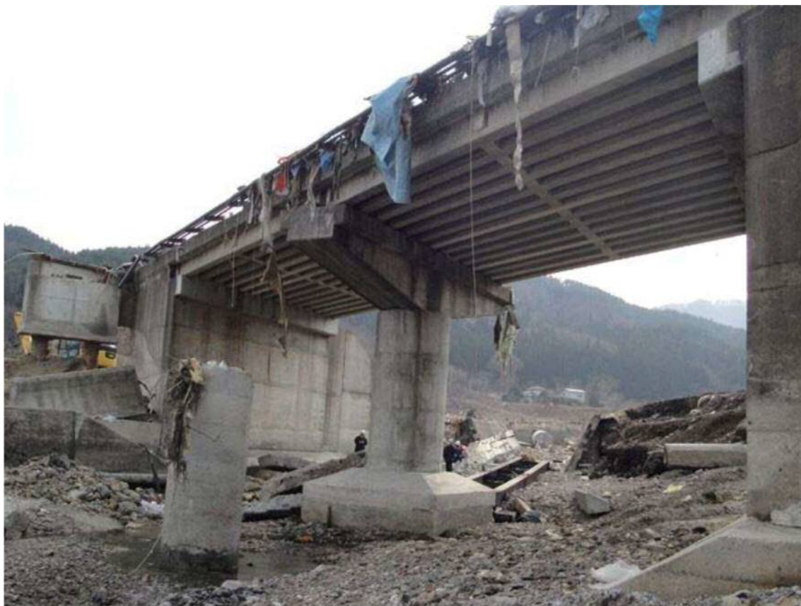
図 2.29 浪板橋側歩道橋(上・下)の流失状況 4)
