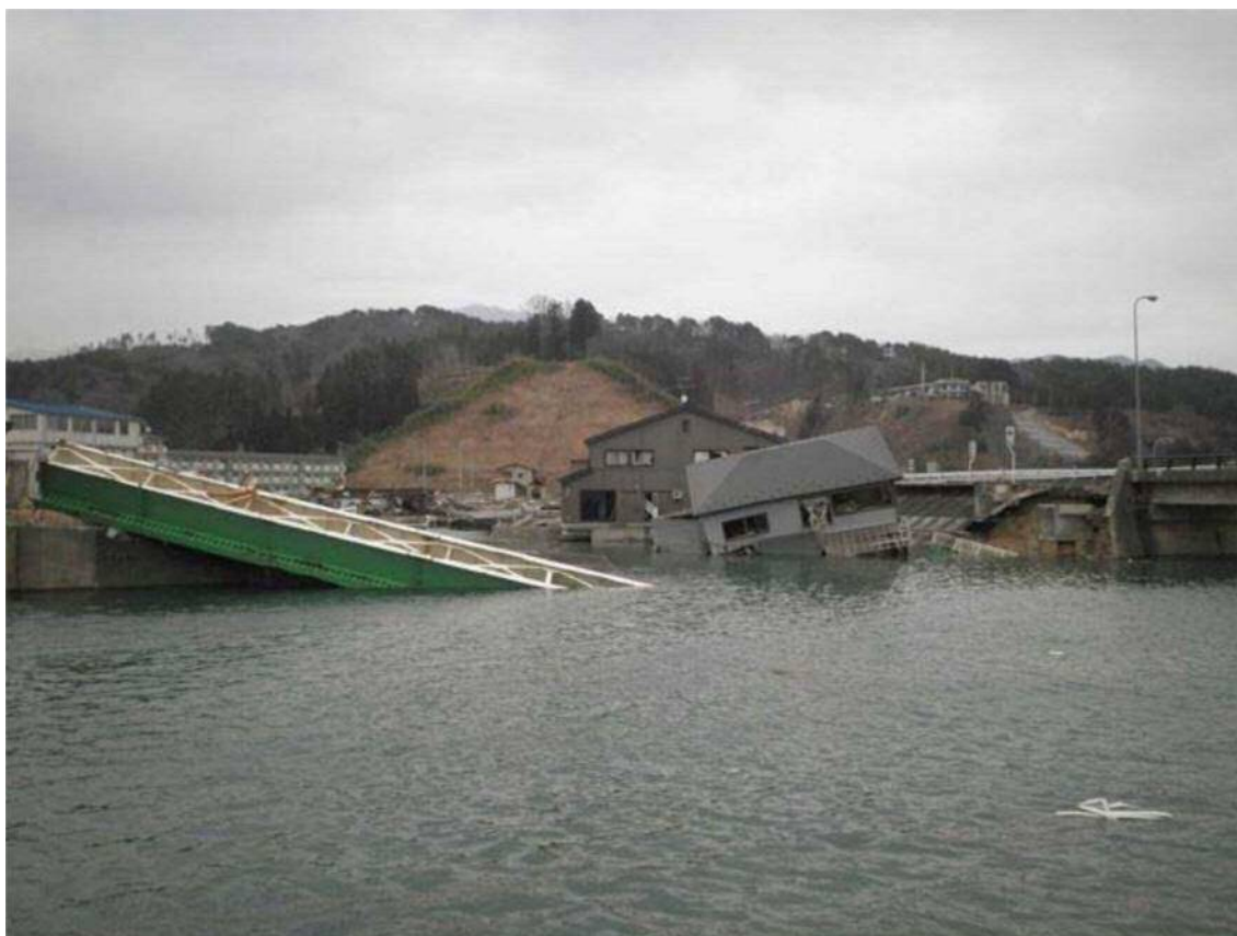
図 2.3 1 宝来橋側道橋の流失状況 4)
