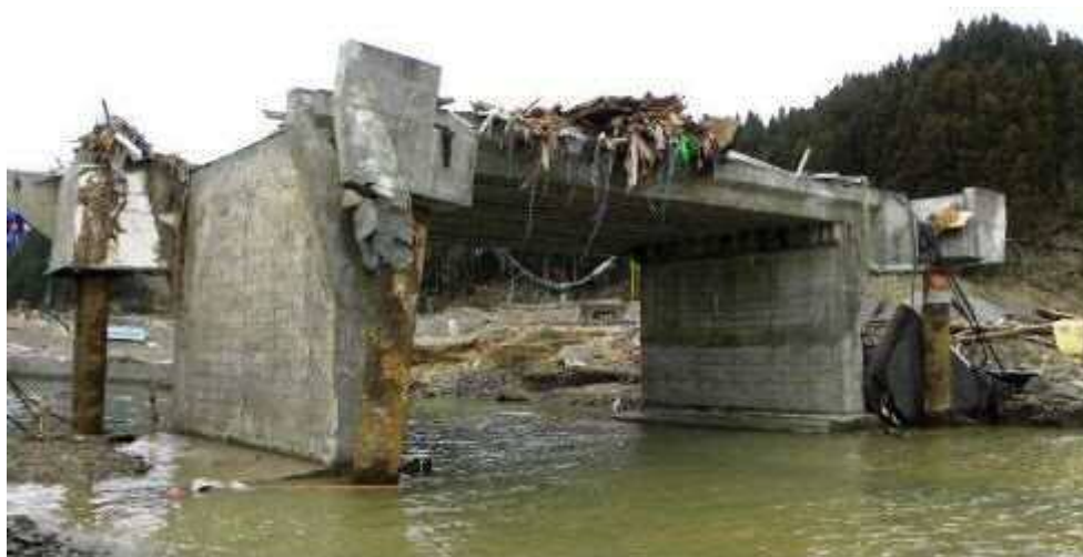
図 2.2 1 二十一浜橋側道橋の流失状況 5)
