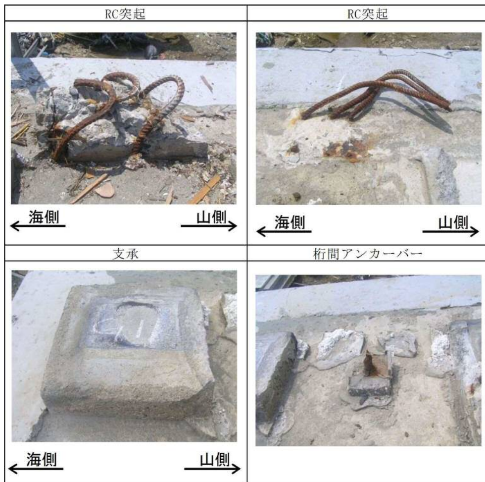
図 3.4 9 支承部損傷状況（歌津大橋） 【Span6】
