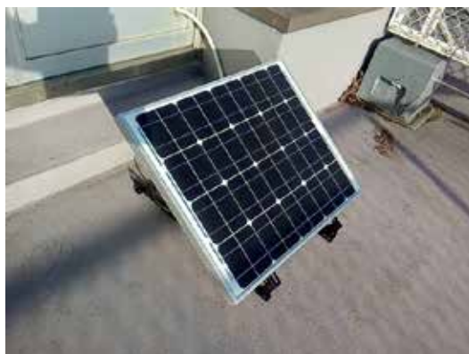
図 12 電気棟屋上への太陽光パネルの設置
