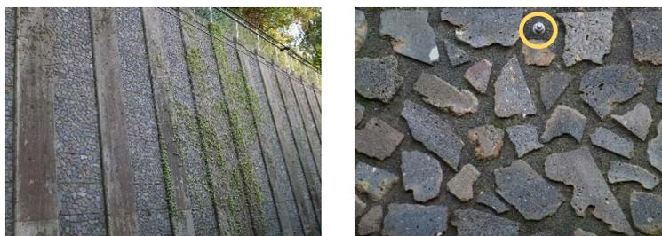
写真-3 JR 四ツ谷駅の線路脇の壁面を構成する火山岩塊(スコリア)スライス貼りつけたボード(左)と、その拡大写真(右、各種断面形状と空隙のあるスライス片、黄色の丸の中はアンカーピン)
