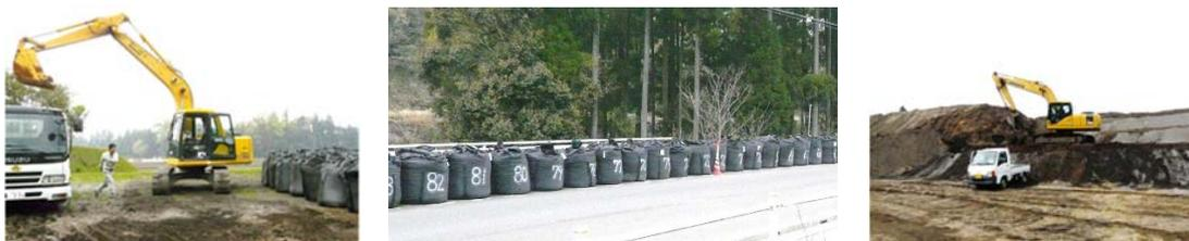
写真-2 降灰の処理状況（左：集積灰を詰めた大型土嚢の搬出，中：山間溪流脇に土石流防止対策で配置した大型土嚢，右：埋立て処分地で降灰と土壌を交互に積層処理中の状況）
