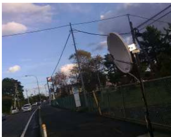
図 13 電波センサのパラボラアンテナの取り付け実験風景
