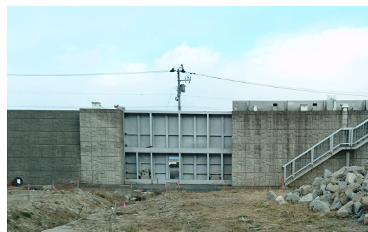
写真1 防潮堤(北浜地区,TP+4m)
