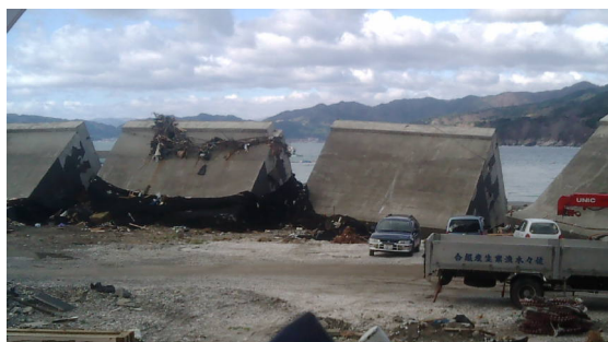
写真 2 転倒した防潮堤 (田の浜地区)
