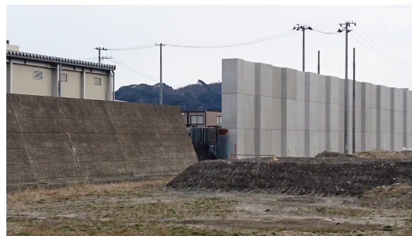
写真4 既存防潮堤(左)と新設防潮堤(右)
