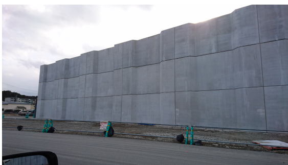
写真 5 新設された防潮堤
