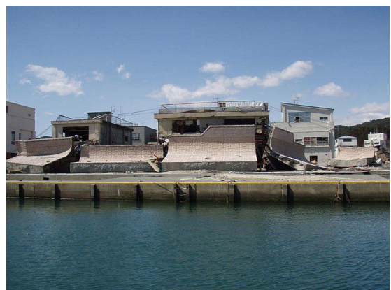
写真 3 転倒した防潮堤 (山田地区) 8)
